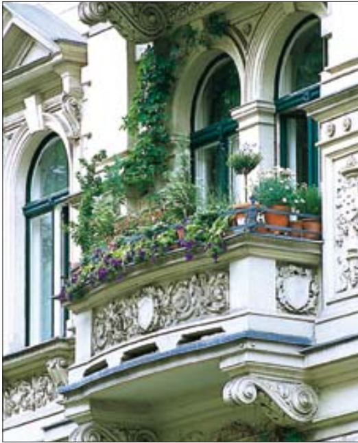
Renaissance-style façade in Riehmers Hofgarten
