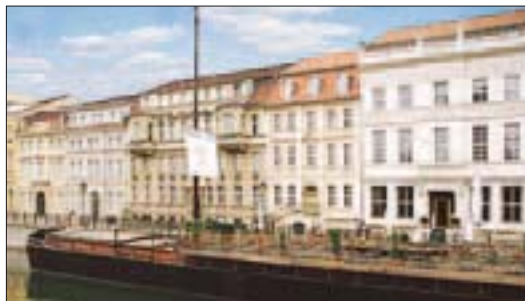
Barges moored alongside Märkisches Ufer
